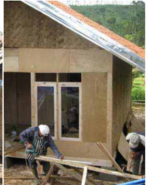
Para tukang sedang menyelesaikan salah satu rumah di Bungbangsari
